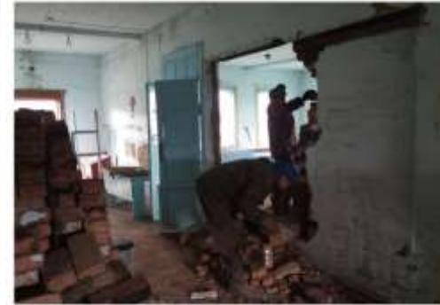
Разборка аварийных печей
